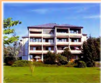
Annaheim der Kreuzschwestern Riesstraße 24 8010 Graz
